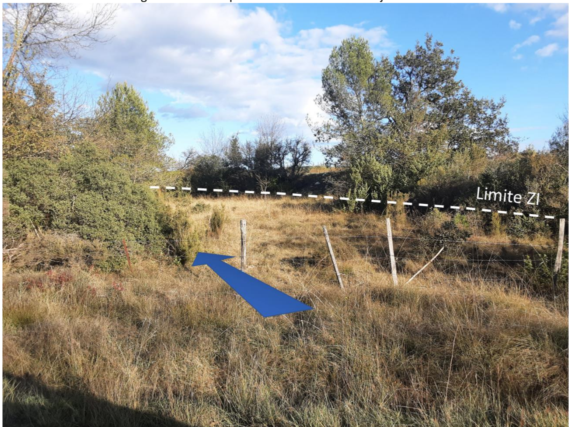
Figure 14 : Vue vers l'aval de la zone inondable depuis le pont de la RD118 à proximité des Planes
